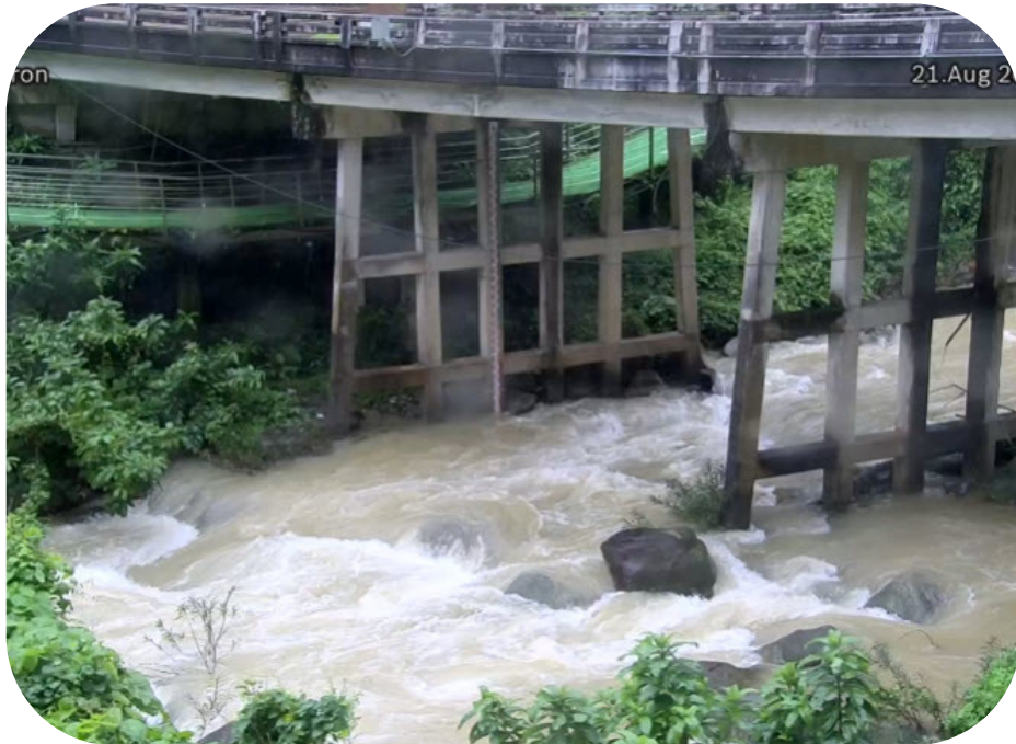
สะพานบ่อน้ำร้อน อ.เมือง จ.ระนอง
